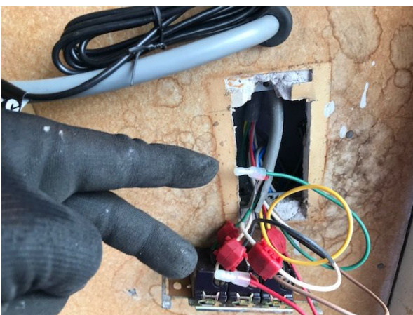
⑥停止スイッチは、切断し圧着します。
